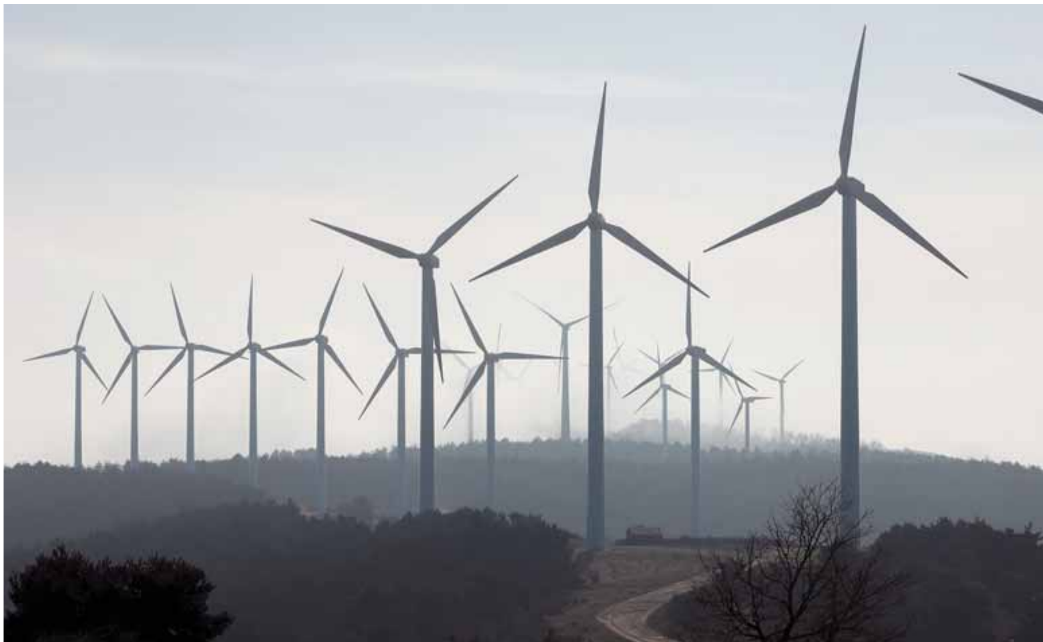
La eólica es la segunda fuente de generación eléctrica en Navarra. En 2021 incrementó su producción anual un 34,7% con respecto a 2020. En la imagen, el parque eólico de Aibar.
